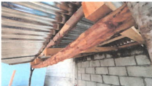
Foto 5: ESTRUCTURA DE TECHO
