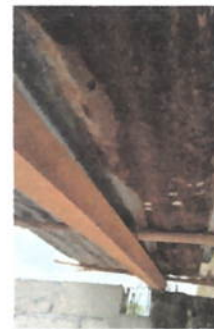
Foto 4: CUBIERTA DE LAMINA
