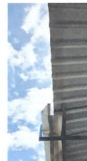
Foto 6: CANALES Y BAJADAS DE AGUA PLUVIAL
