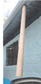
Foto 2: CANALES Y BAJADAS DE AGUA PLUVIAL
